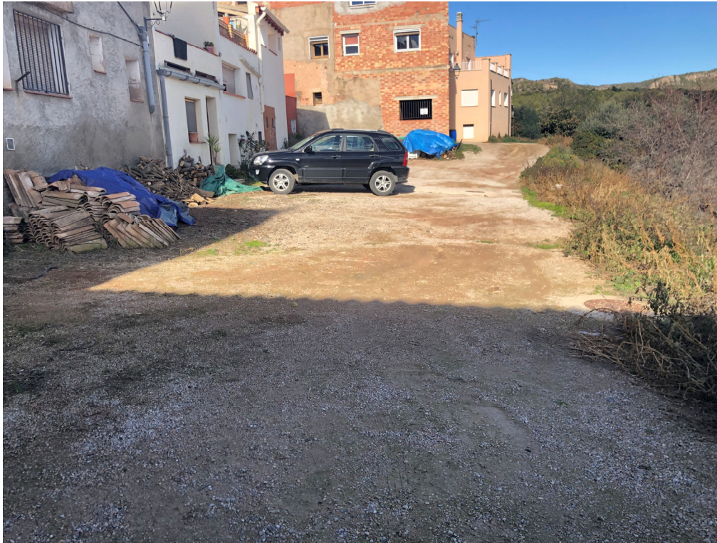
ESTAT ACTUAL PAVIMENT DE TERRA I POUS CLAVEGUERAM EXISTENTS
