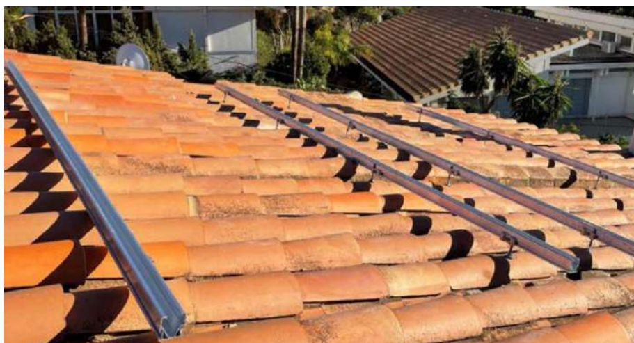
Figura 16 Exemple estructura a teula
