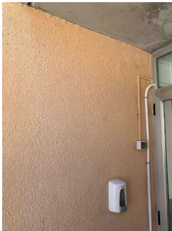
Il·lustració 7 Ubicació inversor fotovoltaic
